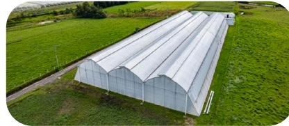
Este invernadero fue construido en acero y presenta un diseño multitúnel tipo arco gótico con doble ventilación cenital. Sus medidas son las siguientes:
